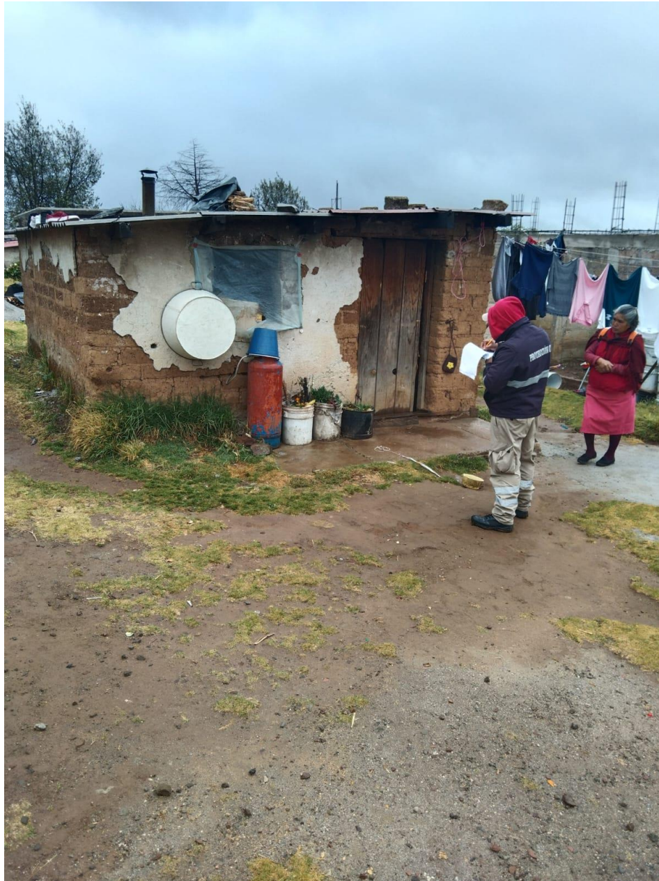
Imagen 26.Verificacion de Vivienda por Riesgo.
