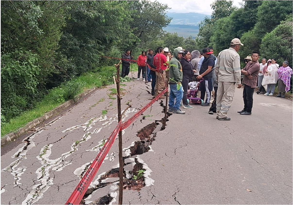
Imagen 13. Acordonamiento de zona de riesgo por agrietamiento.
