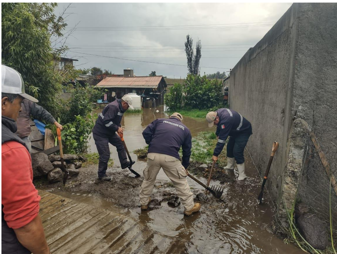
Imagen 6. Desazolve de Cunetas.
