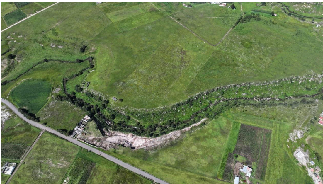
Imagen de una falla en la comunidad de San Jerónimo de los Dolores.
